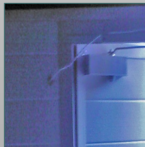
Contacteur de portillon, utilisé lorsque une porte est motorisé, il permet de coupé l'alimentation du moteur lorsque le portillon est ouvert ou mal fermé. Evite la casse ...
